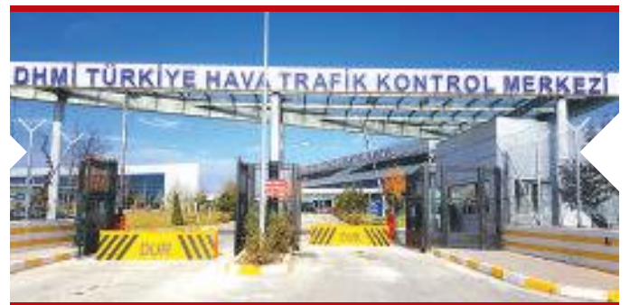
DHMI Türkiye Hava Trafik Kontrol Merkezi - DHMI Turkey Air Traffic Control Center
